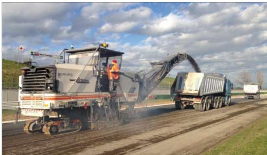
Con il sistema PCS900 si realizzano facilmente sezioni, curve sopraelevate, pendenze di drenaggio variabili e onde longitudinali. La tecnologia Hot Swap consente di passare da una stazione all'altra senza arrestare la fresa stradale
