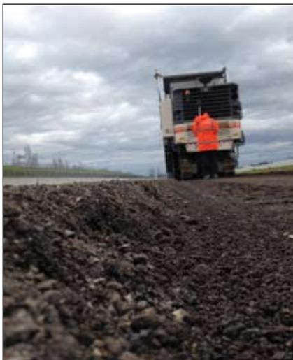
Utilizzando la fresa Wirtgen W 210 dotata del sistema PCS900 si è ottenuto un manto stradale uniforme, realizzato - in tempi molto brevi - limitando gli sprechi di asfalto
